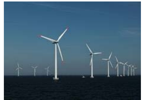
位於丹麥 Rødsand 的離岸風電場，擁有 72 座機組，總裝機容量為 165.6 兆瓦。 Source: Nysted Offshore Wind Farm
