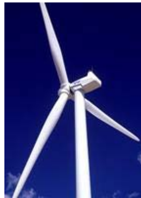
風力發電機: 當風速達到切入風速時，便可啟動渦輪產電。 Courtesy: DOE/NREL Credit: TVIG, Inc.
