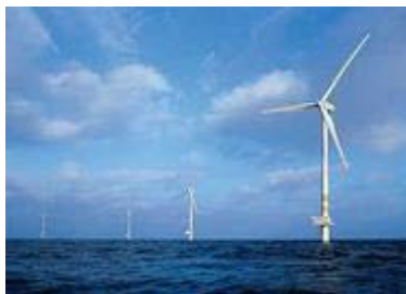
德國 裝機容量約 240 兆瓦的 Butendiek 風力發電場， 位於漢堡。
