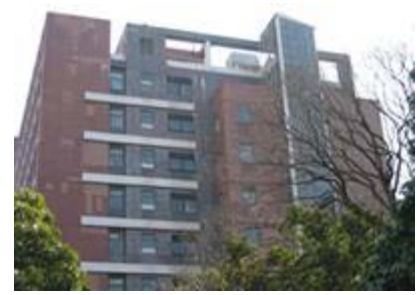
鋪設於香港大學周亦卿樓外牆的太陽能光伏板。
