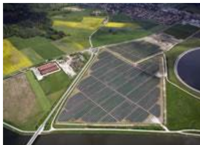
德國 圖為現時全球最大連接於電網的光伏系統之一，這個容量達 10 兆瓦的系統位於巴伐利亞的太陽能發電場。 Photo courtesy PowerLight Corp.
