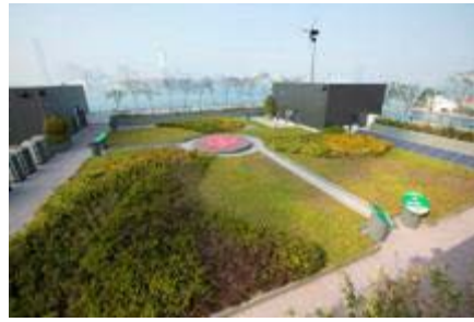
鋪設於港燈馬師道電站大樓天台的太陽能光伏板。
