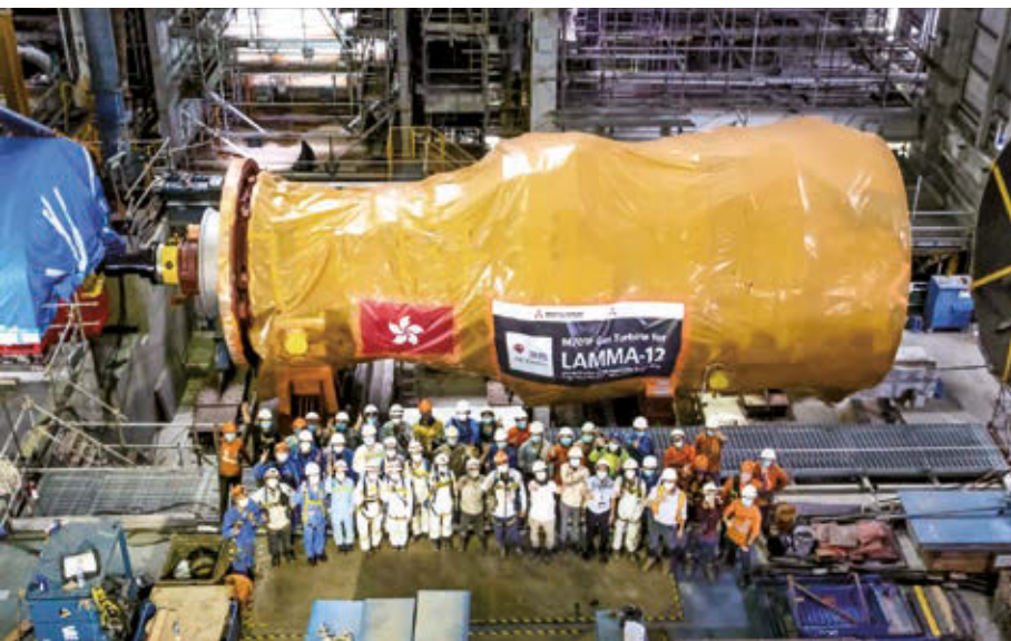
南丫發電廠工程人員將 L12 燃氣輪機安裝在其底座上，機組將於 2024 年初落成投產。
