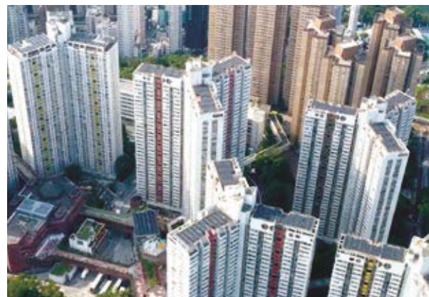
■ 利東邨屋苑頂層的太陽能發電系統透過「上網電價計劃」接駁至港燈電網。
