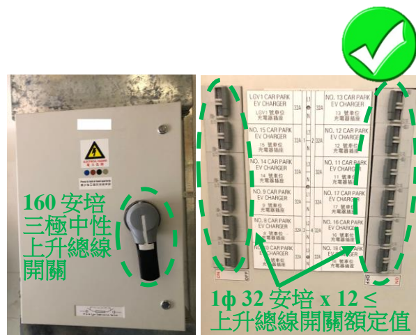
除有負荷控制的電路外，參差額不得應用於供電子多個電動車的專用配電電路。
