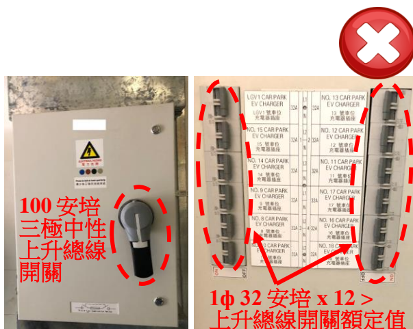
參差額用於供電子多個電動車的專用配電電路。
