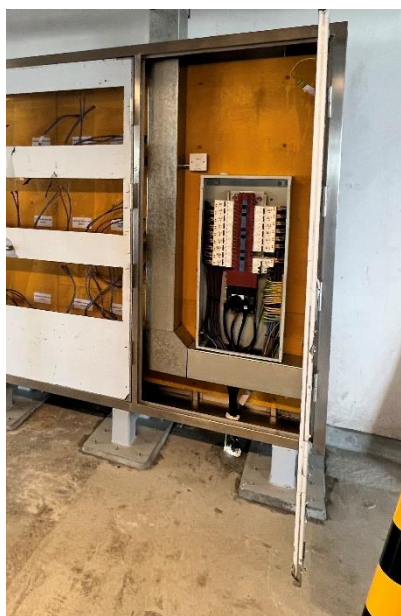
未有按照《電力（線路）規例工作守則》表 9(2) 提供適當額定值的支援熔斷器。
