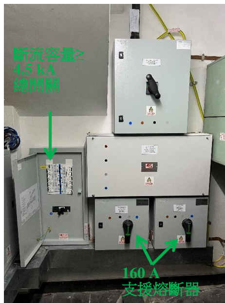
須提供適當的支援熔斷器以滿足《電力（線路）規例工作守則》的要求。
