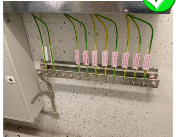
上升接地導體的最小截面積，銅為 70 平方毫米，鋁為 150 平方毫米。
